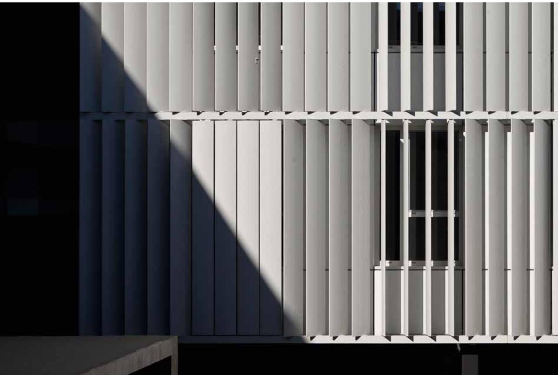
La peau extérieure en brique blanche et les brise-soleil verticaux SUNEAL, situés sur les façades des bureaux, constituent une protection à la fois solaire et visuelle de l'ensemble.
