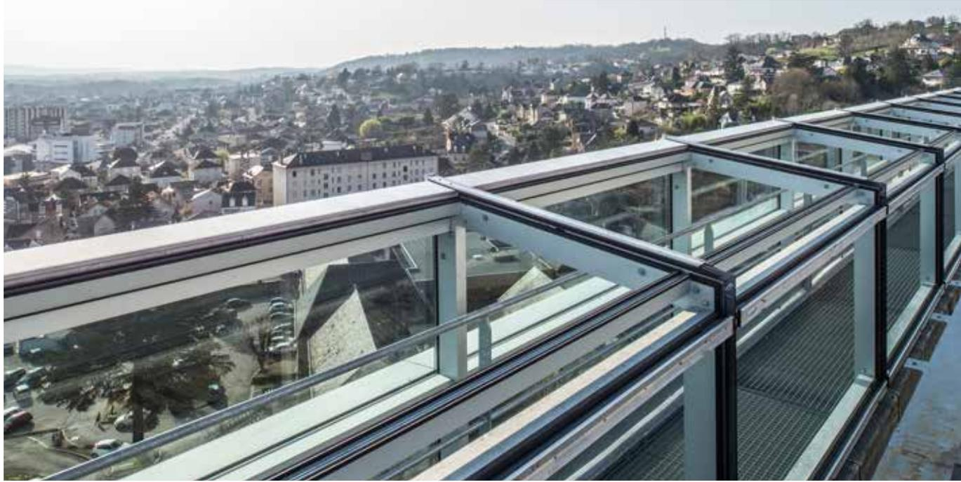
*Rare en France, la rénovation a consisté en la création d'un espace tampon ventilé entre la façade existante et le nouveau mur-rideau GEODE. Cette lame d'air assure la régulation des apports thermiques pour le confort d'été comme d'hiver et la maîtrise de la consommation d'énergie.*
